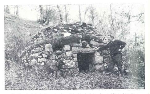
Fig. 7. – Txabola de planta circular y falsa bóveda de tipo hemisférico en la antigua majada de Domingonekoa en el monte Insausti de la Sierra de Aralur navarra. A estas construcciones de falsa cúpula se les conoce con el nombre de «arkoak» – «arkuak» – o también «arkupe».
